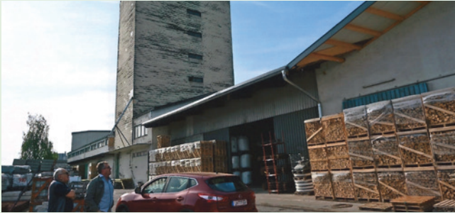
Ehemaliger Getreidespeicher in Ried neben dem Bahnhof
